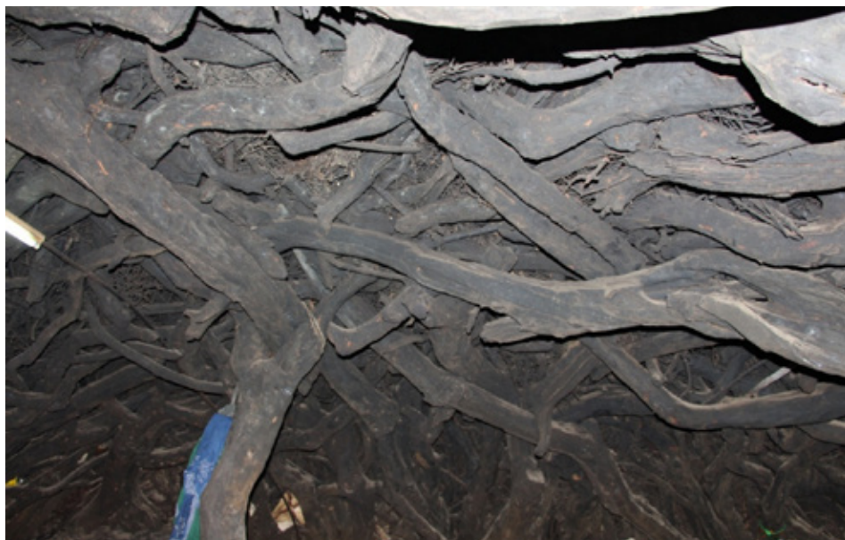
Figure 25. Roof structure of the house at the top of the calotte: column, beam, massive branches and fine infill [Кровна конструкција куће при темену калоте: стубац, греда, масивне гране и ситна испуна]
