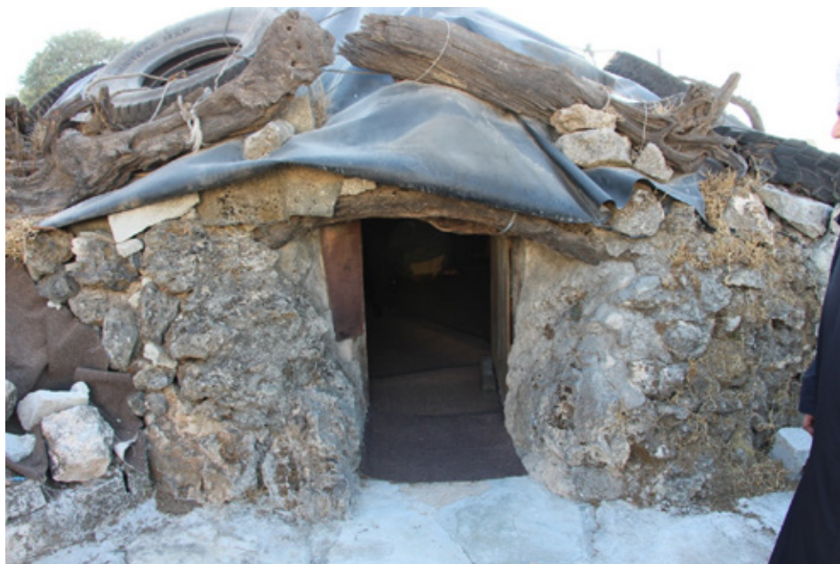
Figure 22. Entrance to the house with a lintel [Улаз у кућу са надвратном гредом]
