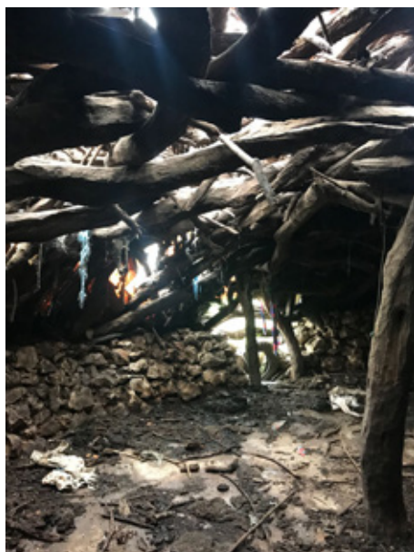
Figure 62. Stone wall with entrance door, two central columns, and part of the roof structure [Камени зид са улазним вратима, два централна ступца, и део кровне конструкције]
