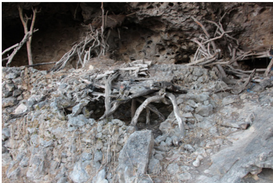
Figure 14. A smaller room formed in the same way as the large one: a stone wall over which the roof cap is placed [Мања просторија формирана на исти начин као и велика: камени зид преко кога је постављена калота крова]
