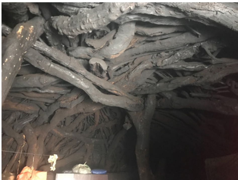
Figure 50. Roof structure: column, beam, massive branches and small branches. Everything is steamed with smoke from the hearth [Кровна конструкција: стубац, греда, масивне гране и ситне гране. Све је препарирано са димом са огњишта]
