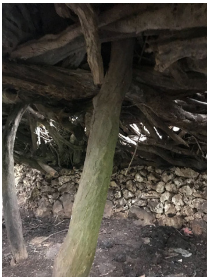
Figure 60. Stone wall, part of the roof structure, two central columns and a horizontal beam [Камени зид, део кровне конструкције, два централна ступца и хоризонтална греда]
