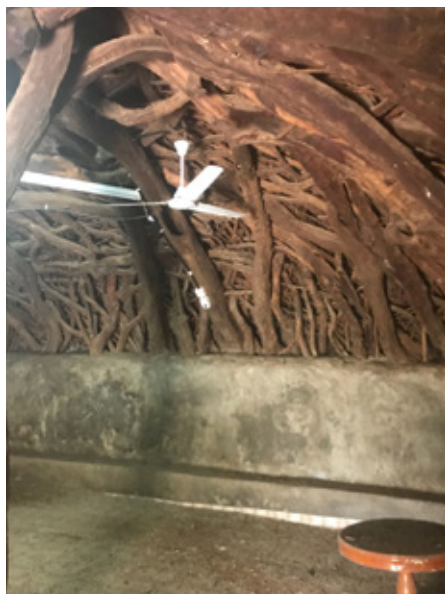
Figure 42. Interior of the house. Plastered part of the wall with a plinth, massive branches extending from the wall to the central beam. In the foreground, a column with a fork at the top and a beam [Унутрашњост куће. Омалтерисан део зида са соклом, масивне гране које се пружају од зида до централне греде. У првом плану стубац са рачвом у врху и греда]
