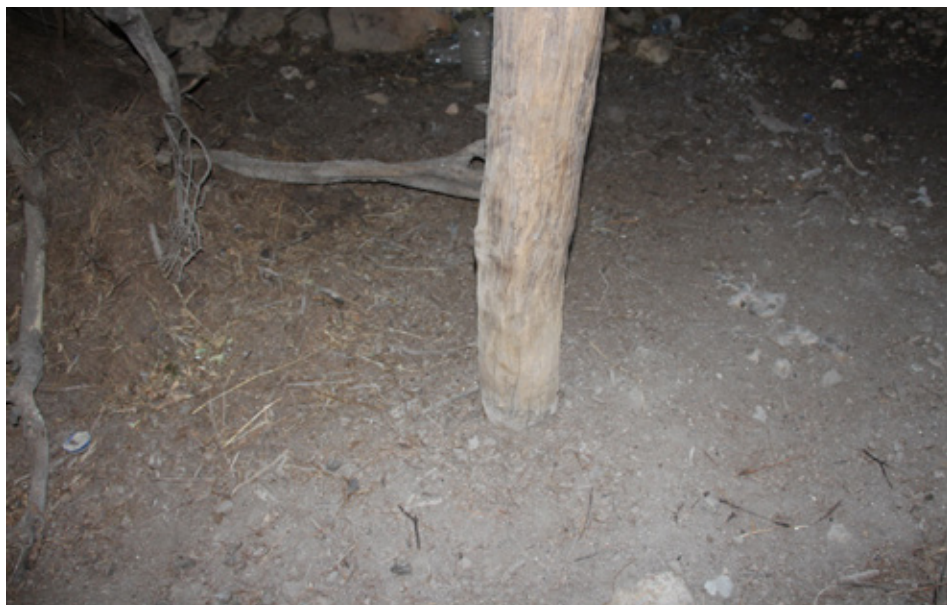
Figure 12. Columns supporting the upper beam of a wooden structure resting on the cave floor [Ступци који носе горњу греду дрвене конструкције наслоњени на под пећине]
