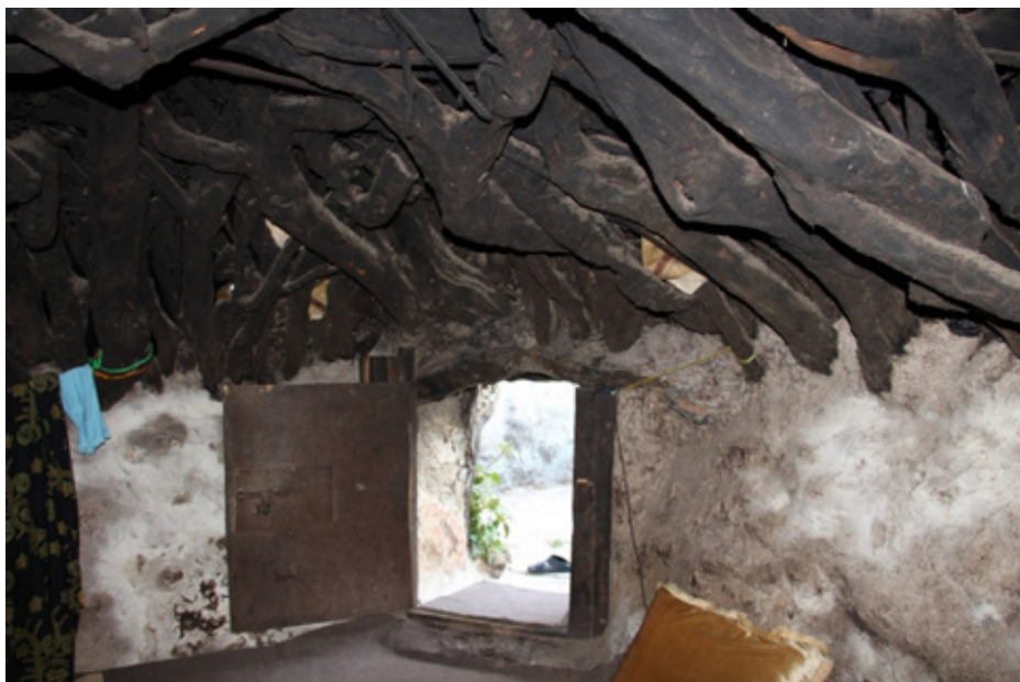
Figure 29. Back door to the house with a door frame, lintel and leaf encased in metal [Задња врата у кућу са довратником, надвратником и крилом опточеним у метал]
