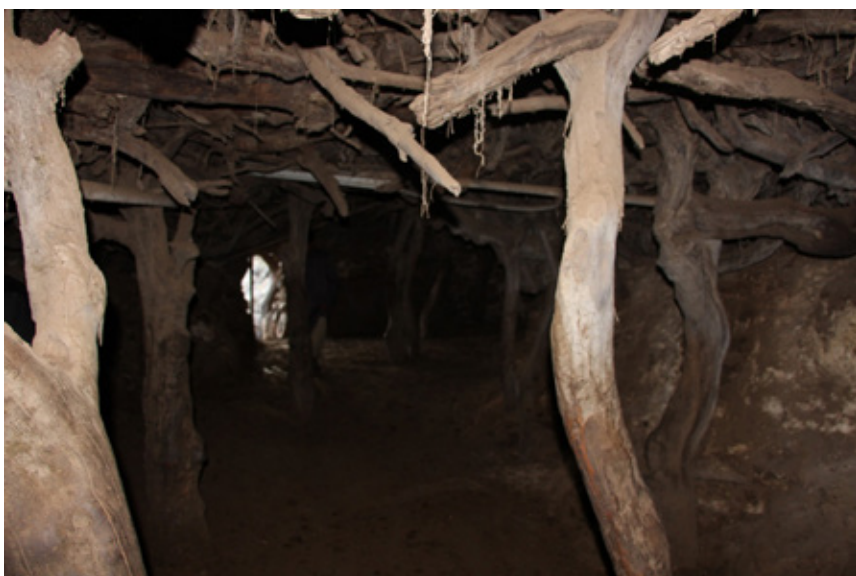
Figure 58. A network of columns supporting horizontal beams and a roof structure [Мрежа стубаца који носе хоризонталне греде и кровну конструкцију]
