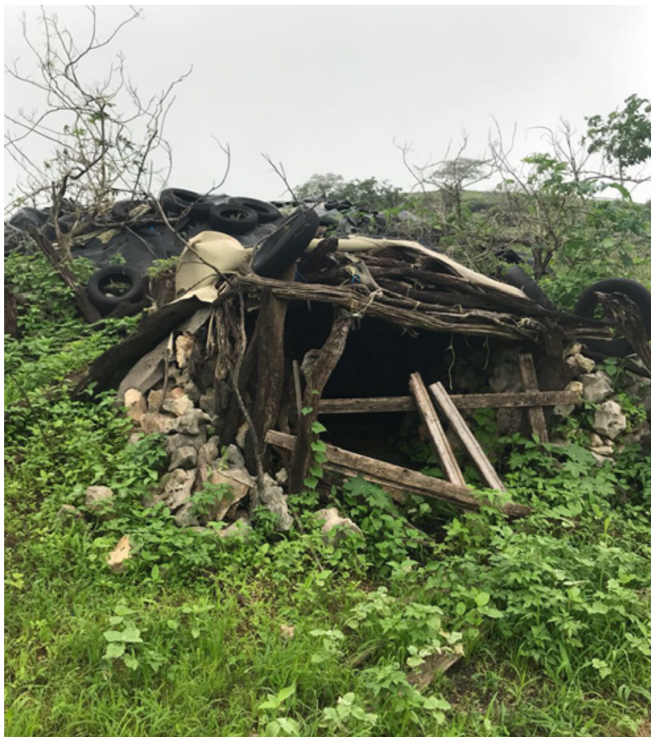
Figure 55. Remains of a stone wall built in drywall, columns and part of the roof covering [Остаци каменог зида зиданог у сувозиду, ступци и део кровног покривача]
