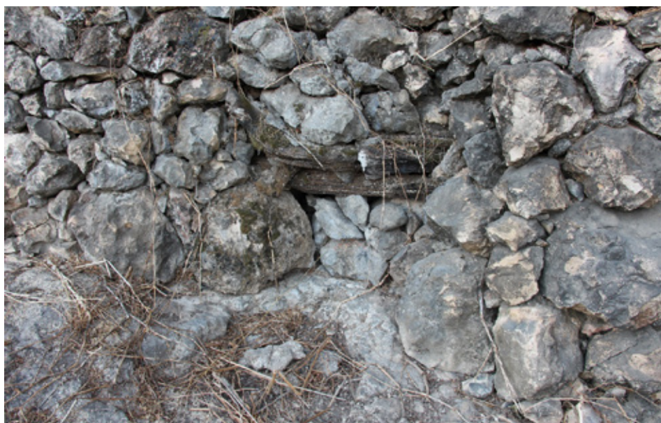
Figure 13. A hole in a stone wall to drain water from a room [Отвор у каменом зиду за испуштање воде из просторије]
